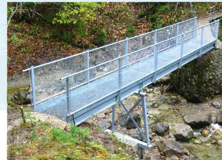
Die Tragkonstruktion ist aus gewalzten Stahlprofilen hergestellt. Die Rohrgeländer wurden vor Ort angeschraubt. La structure porteuse est fabriquée en profilés d'acier laminés. Les balustrades tubulaires ont été vissées sur place.
