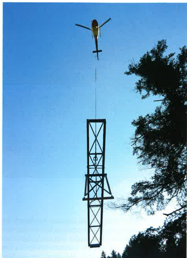
Die Bodenkonstruktion inklusive Tragjoch wird angefliegen. La structure du sol et la pile porteuse arrivent par voie aérienne.
